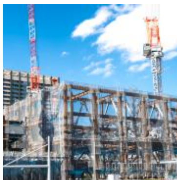
建設・工事現場
